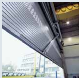
Система ветровой защиты (WPS = Wind Protections System)
